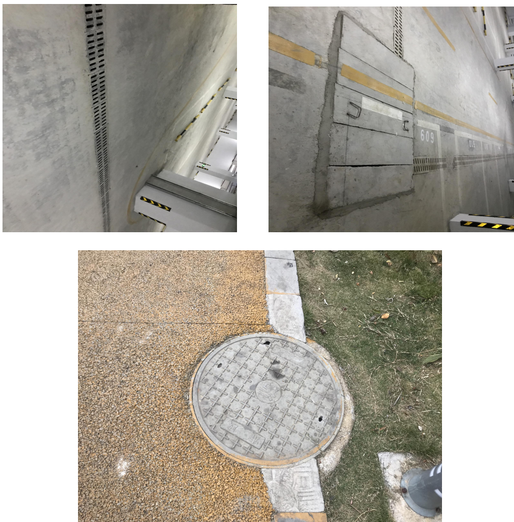
图 4-1 污水处理站（废水环保设施）
